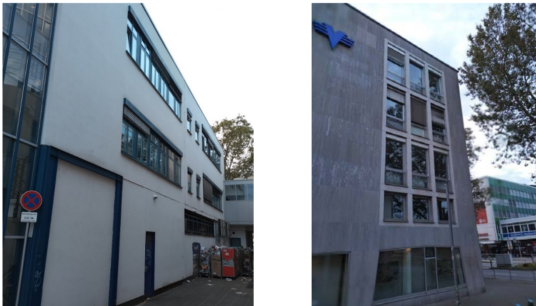
Abbildung 14: Potentiell für die Zwergfledermaus geeignete Spaltenquartiere hinter Rollladenkästen (Beispiele) an den im Untersuchungsgebiet befindlichen Gebäuden.
