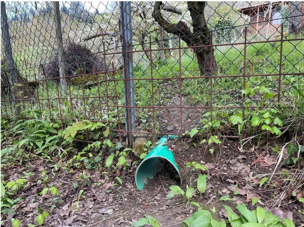
**Abbildung 7.8-1.** Mit in den Boden eingelassenen Baustahlmatten sind Einzäunungen wildschweinsicher. Hier ist ein Kleintierdurchlass integriert (Handschuhsheim, Gartenverband im Gewann „Dallgarten“, umgesetzt 2018).
