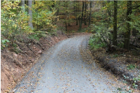
Der Verbindungsweg im November 2016 nach Sanierung
