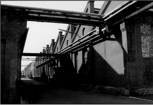
Detailansicht der Shedfassade im Furukawa-Gelände Foto: Stadtplanungsamt Heidelberg
