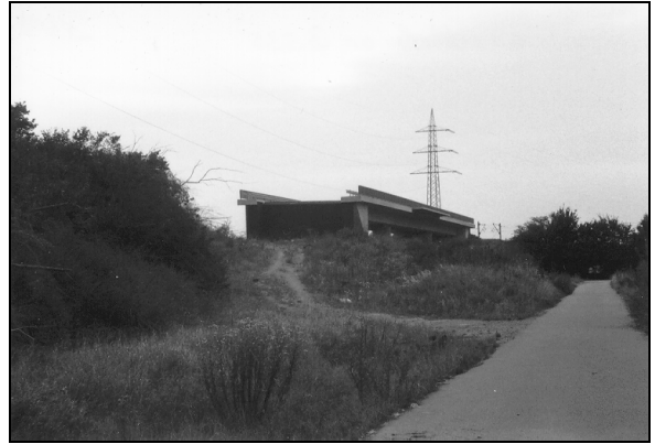
Bauwerkstorso: Anschlußbrücke an die B 535
