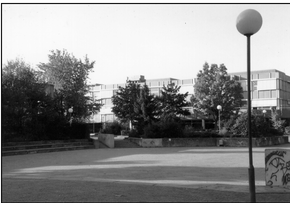
Schulhof der Internationalen Gesamtschule
