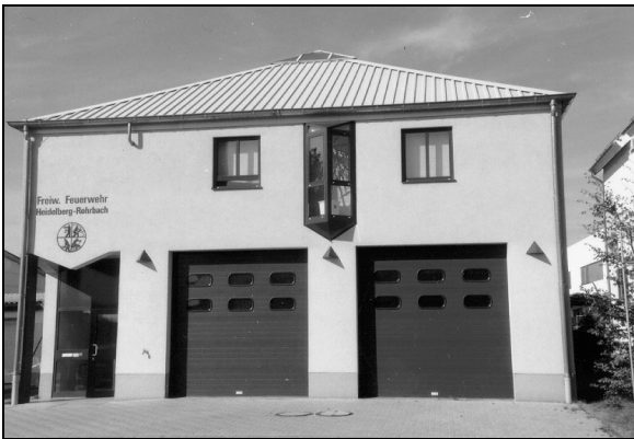
Das Feuerwehrhaus in der Fabrikstraße
