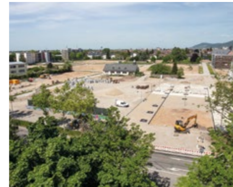
Der großflächige Abriss von Altbauten ist abgeschlossen – die Baufelder sind bereit für neue Nutzungen
