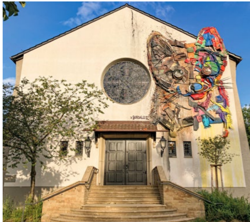
In der ehemaligen Militärkirche befindet sich der neue Stadtteiltreff für die Südstadt. Die Fassade wurde im Rahmen des Metropolink-Festivals gestaltet
