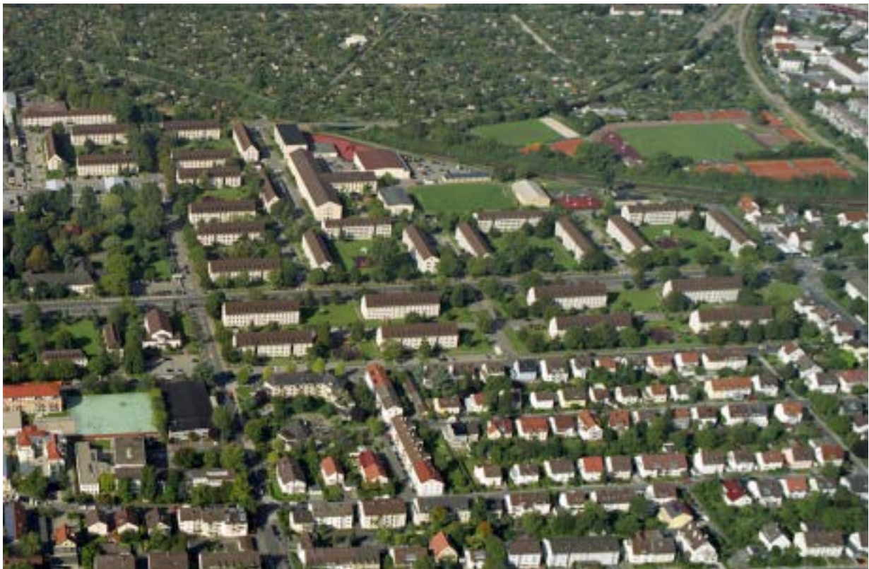
Schrägluftbild von Südosten (Quelle Kay Sommer 2010)
