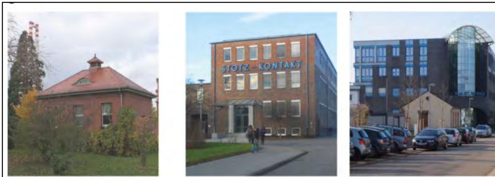
Abbildung 16 Beispiele für vorhandene Gebäude mit Klinkerfassaden
