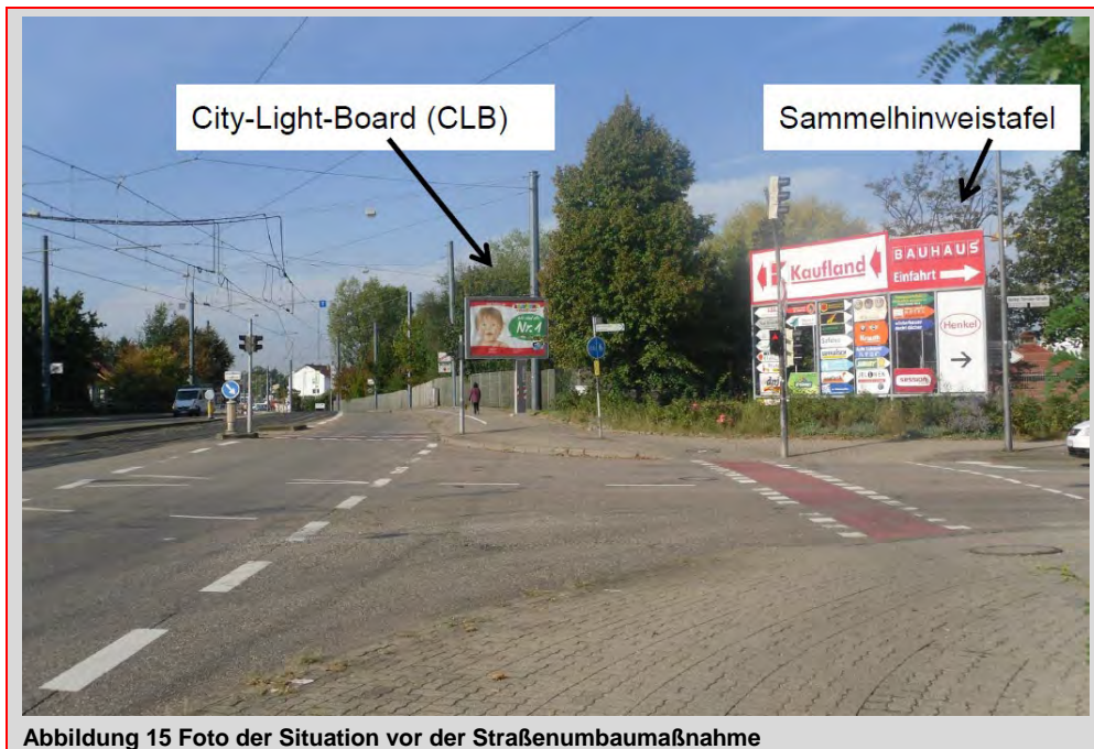
Abbildung 15 Foto der Situation vor der Straßenumbaumaßnahme
