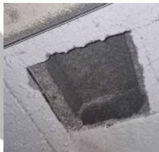
Bauwerksuntersuchung inkl. Schadstoffuntersuchung
