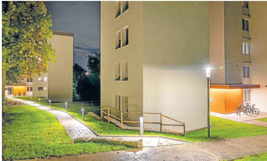
Die GGH hat in elf Jahren 15 Gebäude auf dem Boxberg umfangreich energetisch saniert. Zum Abschluss sind 2022 auch die Außenanlagen neugestaltet worden. (Foto GGH/C. Buck)
