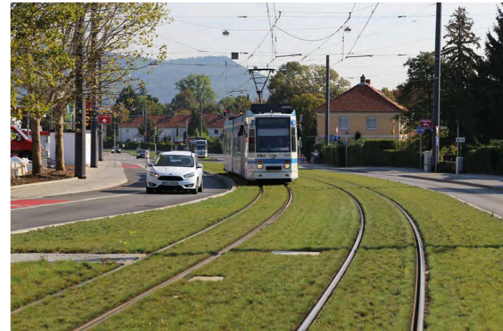
Umgestalteter Straßenabschnitt (Eppelheimer Straße)
